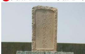
明治33年(1900)9月に完成し、函館港の改良工事には取り壊された弁天岬台場の石垣が、舟入間防波堤や護岸潮堤として使用され、残っている。記念碑の備前産の御影石も土塁石垣に使われていたもの。
